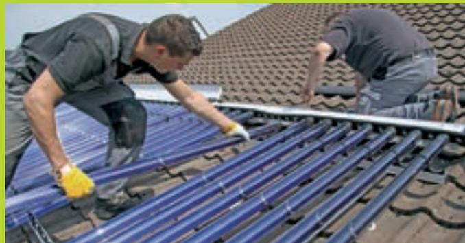
Eine Solarthermieanlage auf dem Dach ist eine gute Ergänzung zur Ölheizung.
