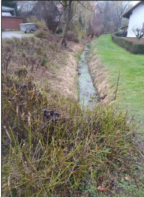
Abb. 2: Der Aulebach Richtung Osten.
