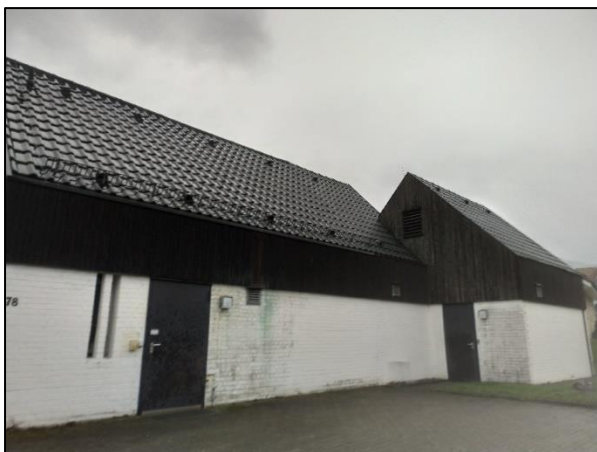
Abb. 4: Scheune am östlichen Ende des Untersuchungsgebiets, welche potentielle Quartiere für Fledermäuse bietet.
