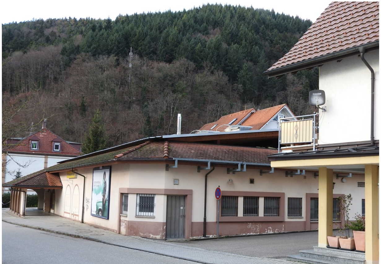
Abbildung 3: ehemaliger Supermarkt, Gebäudeansicht von SO nach NW (21.12.2019)
