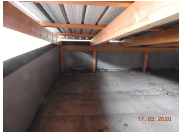
Abbildung 7: Dachstuhl/ keine Spuren (17.03.2020)
